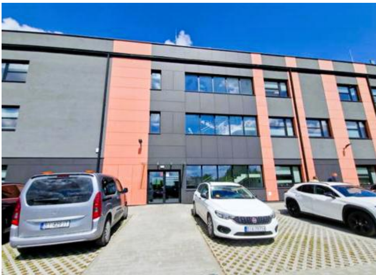
Rys. 12. Wielofunkcyjny budynek administracyjno-społeczno-kulturalny w sołectwie Dobrzyniewo Duże Zdjęcie: Edyta Tomczyk.
