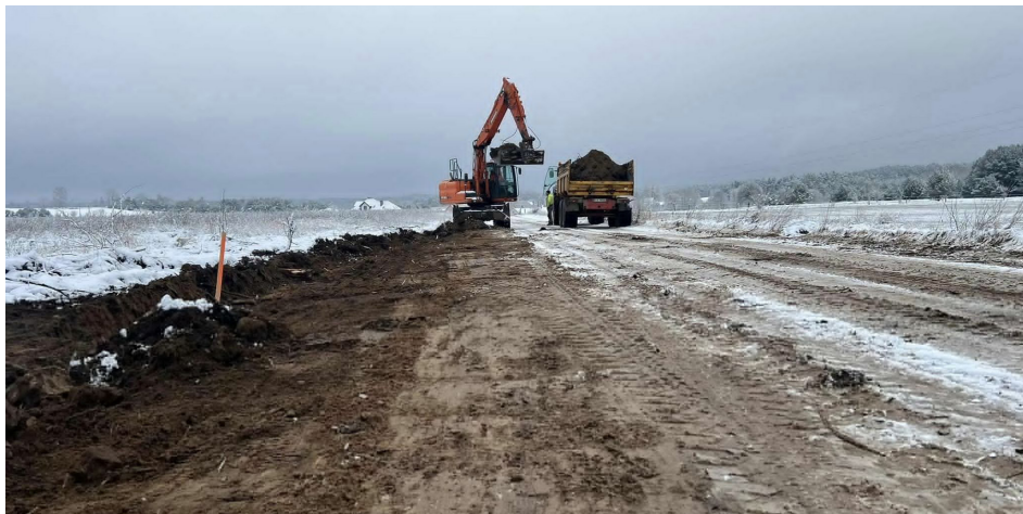
W listopadzie rozpoczęła się przebudowa drogi gminnej Chraboby – Kulikówka etap I.
