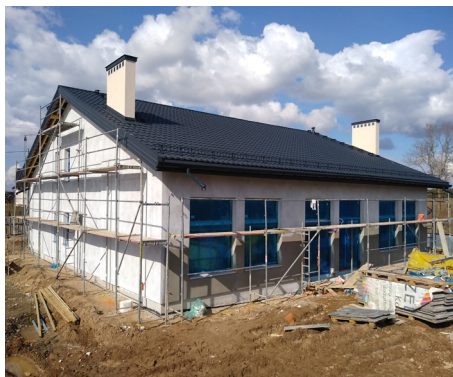
W Letnikach powstaje świetlica z pomieszczeniami przeznaczonymi na potrzeby ochrony przeciwpożarowej
