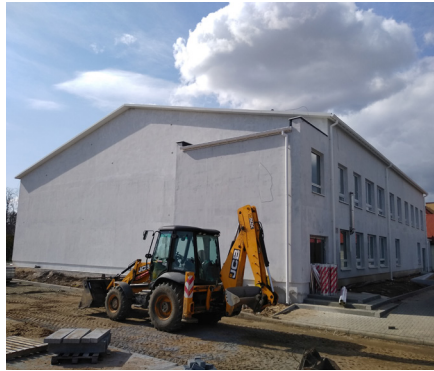
Budowa w sali sportowej w Fastach
