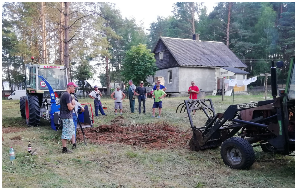
Mieszkańcy Kulikówki porządkują teren pod budowę świetlicy
