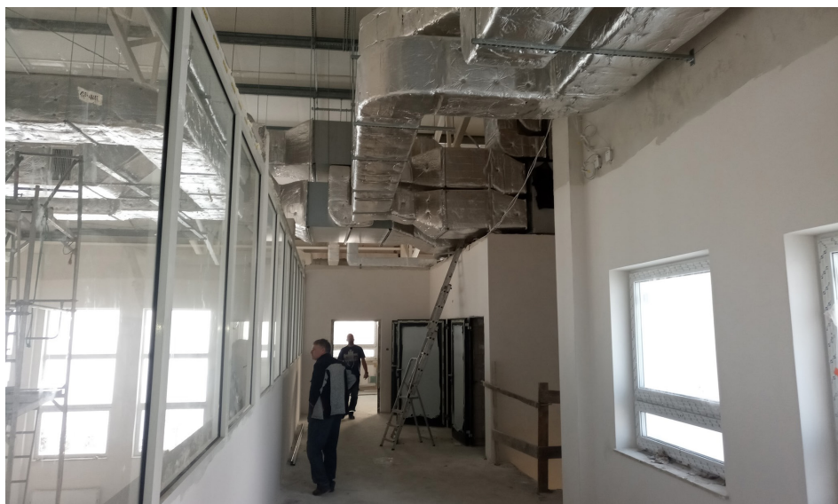
Prace wykończeniowe w sali gimnastycznej w Fastach
