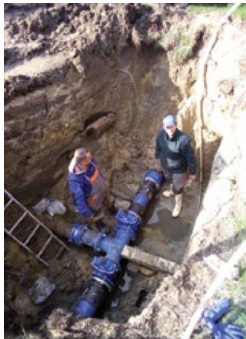
Prace przy wymianie węzła zasuw
