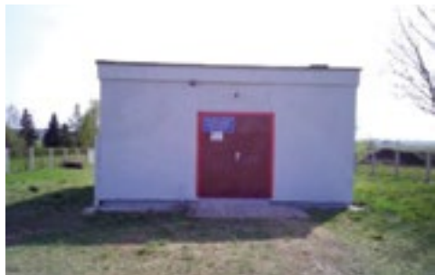
Stacja Uzdatniania Wody w Jaworówce jak nowa
